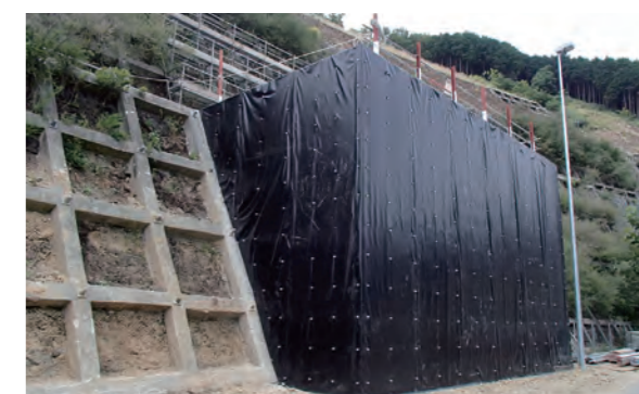
▲遮水シート敷設完了
