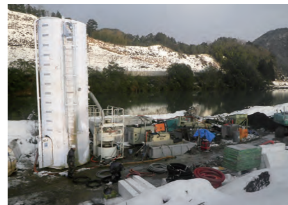
▲エアモルタル(現場設置プラント)
