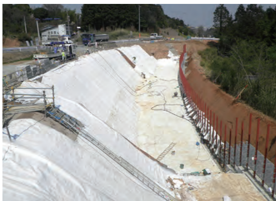
▲防水シート敷設
