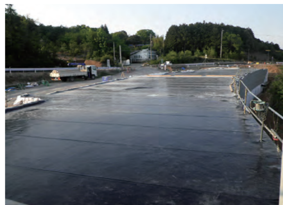
▲遮水シート敷設状況
