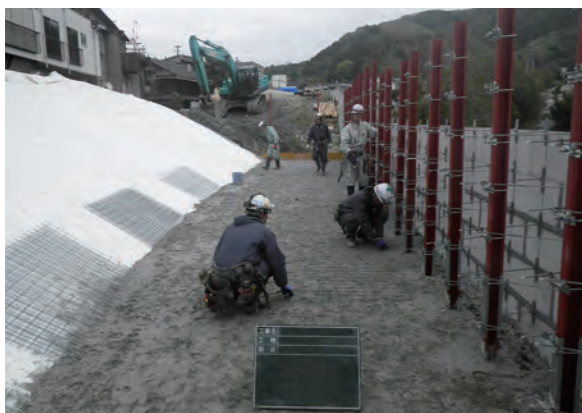
▲溶接金網敷設状況
