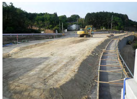
▲天端基礎型枠設置及び路床材敷均し
