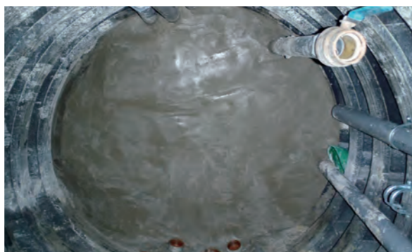
▲閉塞壁・注入孔等設置完了
