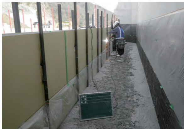
▲緩衝材設置状況
