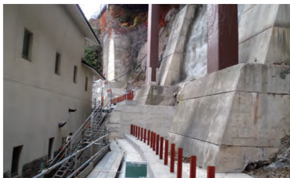
▲壁面材用基礎打設完了
