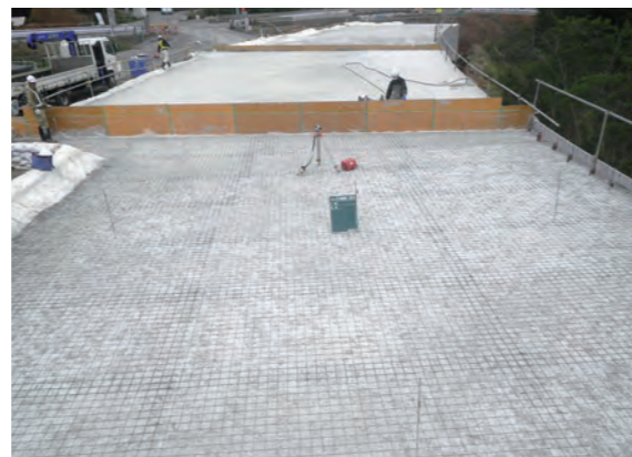
▲溶接金網敷設状況
