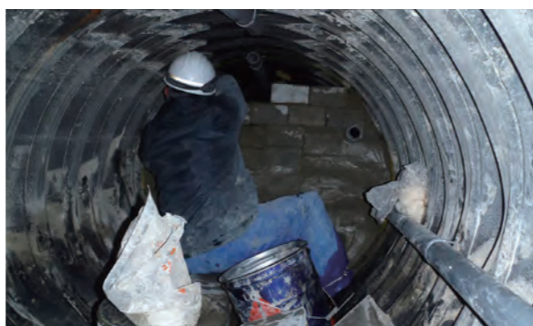
▲閉塞壁設置状況
