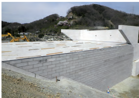
▲壁面材設置完了
