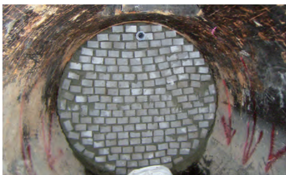
▲閉塞壁設置状況
