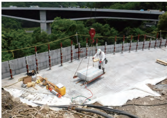
▲壁面材設置状況
