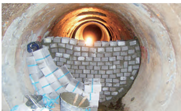
▲閉塞壁設置状況
