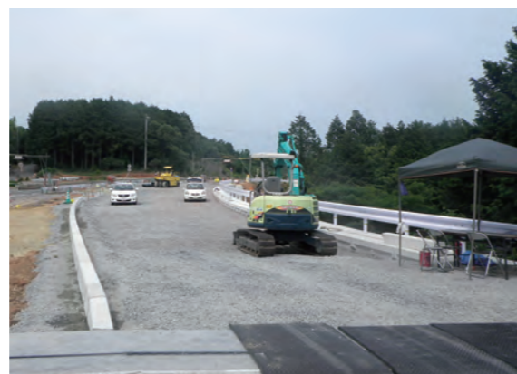
▲路床材転圧完了
