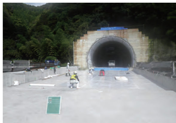
▲遮水シート敷設状況
