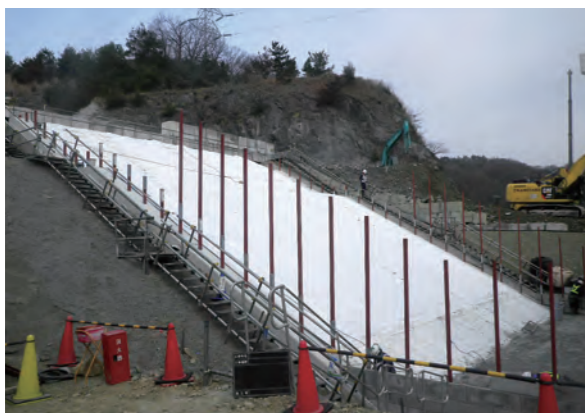
▲防水シート敷設完了
