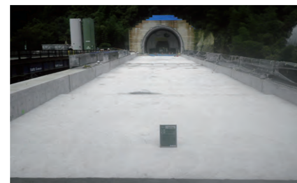
▲トンネル貫通状況
