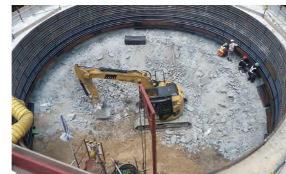
▲深礎掘削状況
