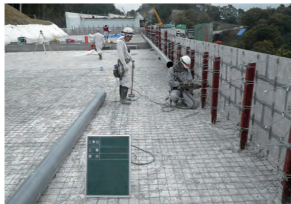
▲排水管設置状況
