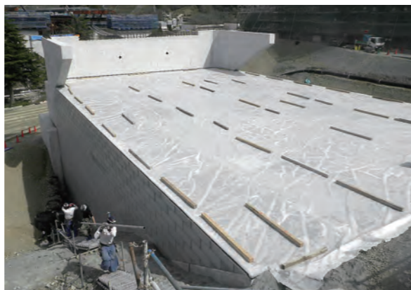
▲遮水シート敷設完了
