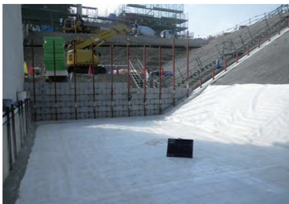
▲壁面材取付状況
