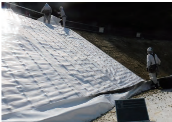
▲防水シート敷設状況
