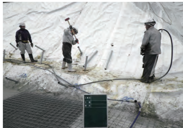
▲定着材設置状況
