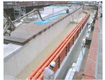
⑧ 多条埋設管理戻工事
