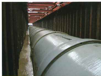
⑨ 大口径管無人化埋戻工事
