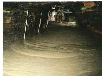
⑬ 亜炭廃坑埋戻試験工事
