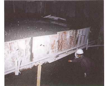
④ 養生3日でのリフト打設の例
