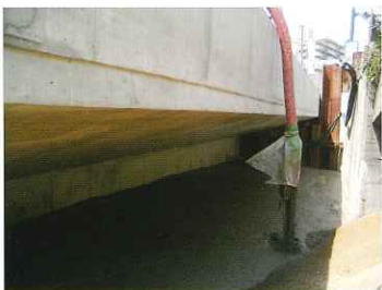
⑤ 橋台背面裏込工事
