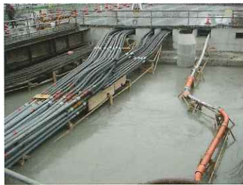
⑥ 広域地盤置換工事
