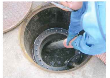
⑯ 都市インフラ廃止管閉塞工事
