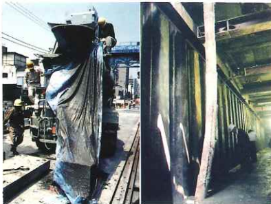
① 共同溝直投打設の例
