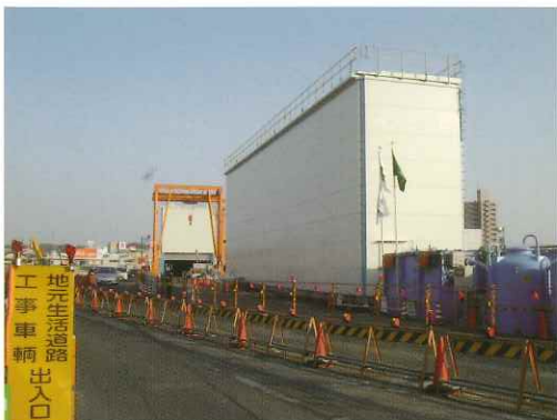
⑨ 道路占有に設置された仮設プラントの例
