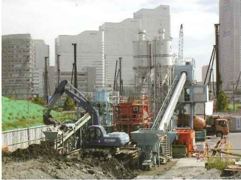
① 大規模仮設プラントの例
