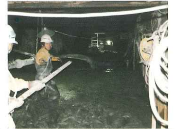
⑫ RC 躯体天端外防水試験工事
