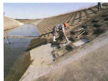
⑰ 護岸空洞補修工事
