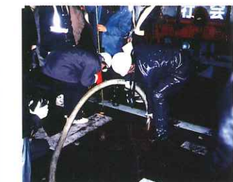
⑱ 路面化空洞充填工事
