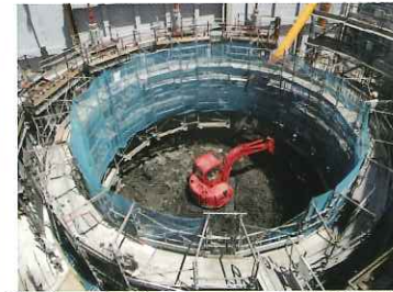
⑪ オープンケイソン遮水壁構築工事
