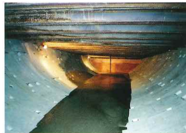
⑩ シールドインパート埋戻工事
