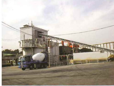
② 都市部常設プラントの例（その1）
