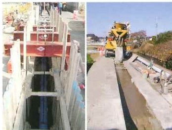
⑮ 国交省社会実験下水管工事
