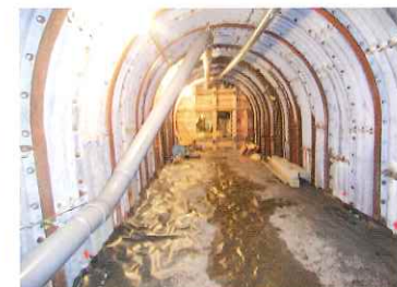
⑭ 地滑地帯排水トンネル閉塞工事
