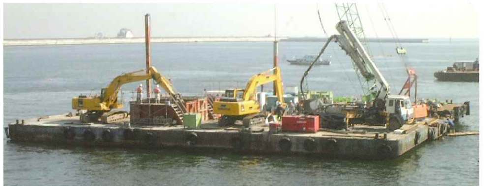
⑩ 海上に設置された仮設プラントの例
