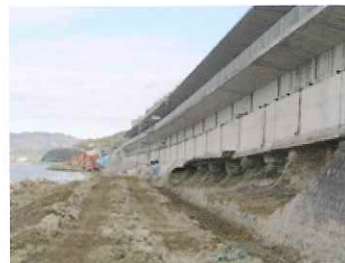
⑲ 洞門基礎補修工事
