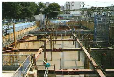
⑦ 建築基礎工事（ラップルコン代用）
