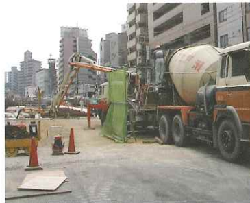
② 共同溝ポンプ圧送打設の例
