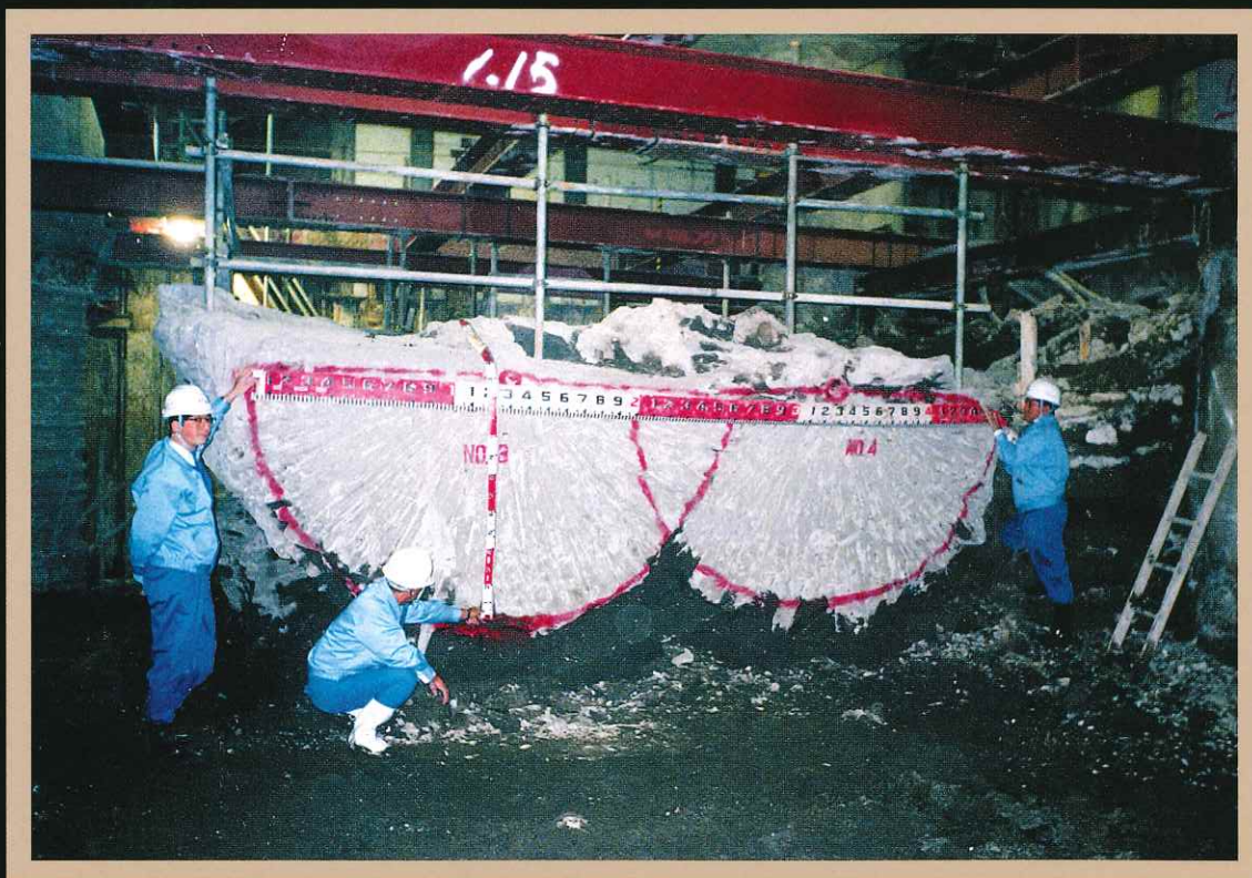
水平施工出来形
