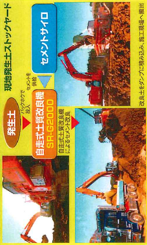
改良土による盛土施工中の平田工区の様子 早期開通を目指し、工事が進められています。
