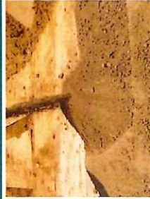
改良土排出時の落下抑塵による粉じんもほとんど発生しない。 Hi-SSは、発生土をリサイクルする。
