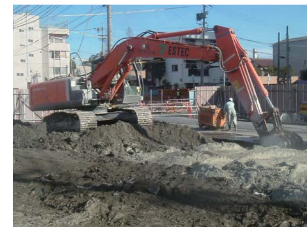
バックホウによる混合攪拌
