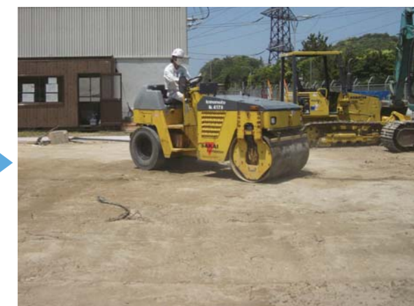
ローラーにて転圧
