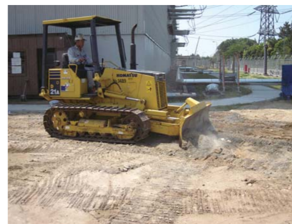
ブルドーザにて整地
