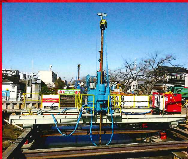
▲移動式架台(スライドベース)施工
