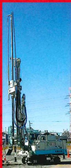
▲自走式機械(ミニ杭打機)施工
