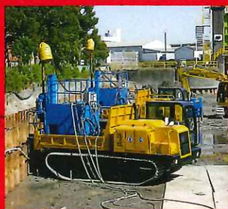
▲自走式機械(キャリアダンプ)施工
