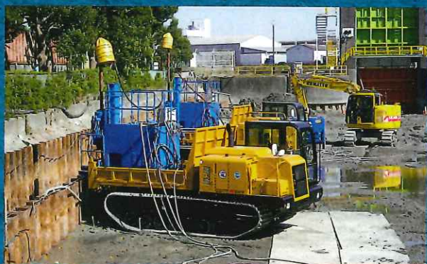
▲自走式機械(キャリアタンク)施工
