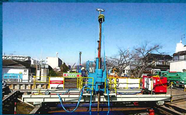
▲移動式架台(スライドベース)施工
