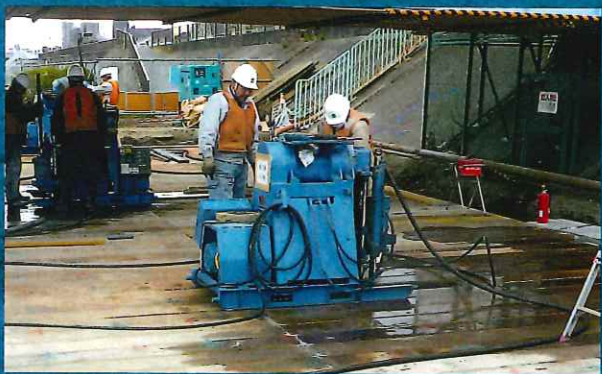
▲空頭制限施工
