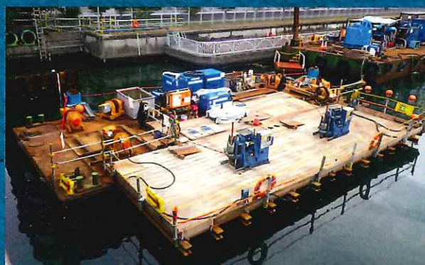
▲改良台船施工
