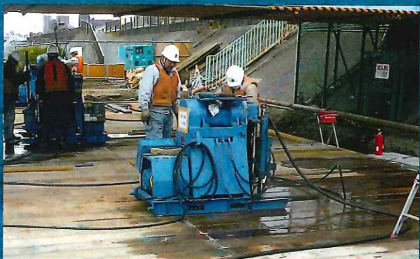
▲空頭制限施工
