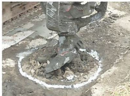
地盤改良体(φ1,600)破碎施工
