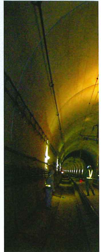
鉄道トンネル
