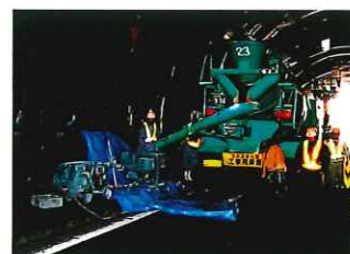
JETMS場内圧送例
