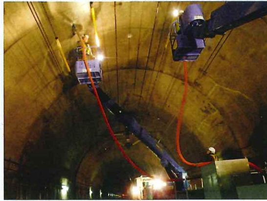
鉄道トンネル
