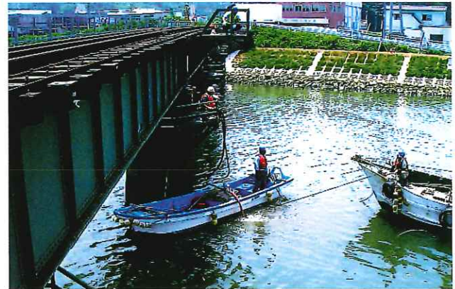
水中打設状況
