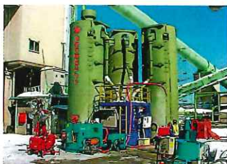
場外プラント設置状況
