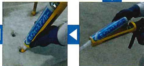
④アンカー定着孔へ注入
