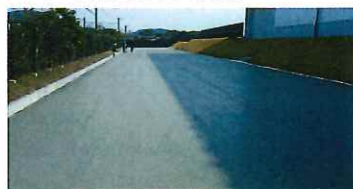
仕上がり状況
