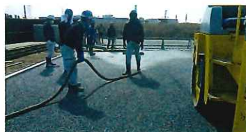
スラリー供給状況(注入状況)
