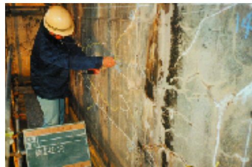
◀ アルカリ骨材反応例
