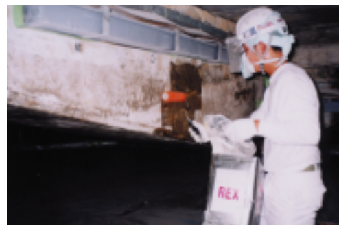
◀ 塗布・含浸工法
