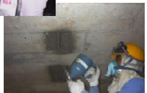
モルタル・コンクリート混和工法 ▶
