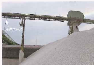
▲地上30m 地点での作業
