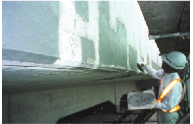
▲ 埋め戻し状況
