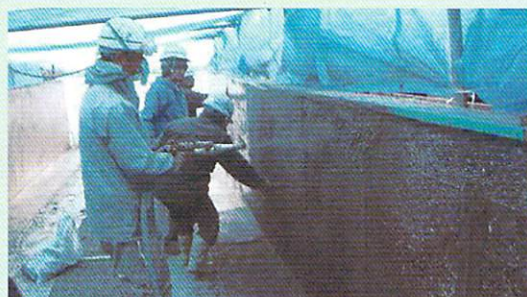
リフレモルセットD吹付け状況
