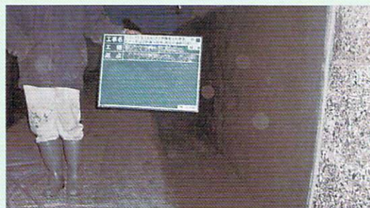
リフレモルセットD施工完了
