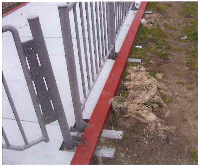
切欠き部の加工例
