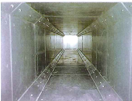
■ 暗渠（BOXカルバート）
